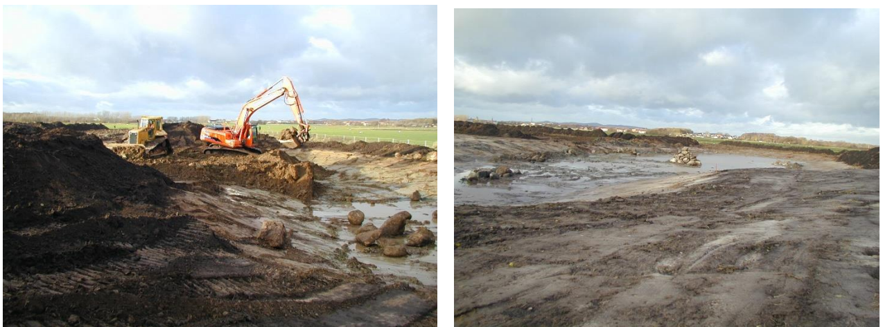
Fig. 9. De nya dammarna byggs. Stenröset mitt i dammen finns fortfarande kvar
